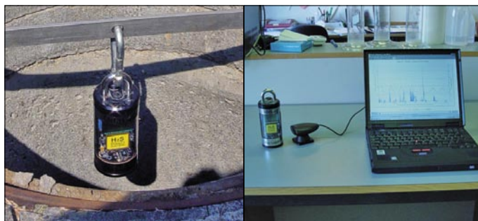
Billede 3: Nuværende måleudstyr hhv. monteret i brønd og ved dataoverførsel
