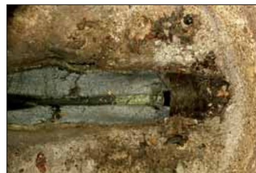
Den sorte ledning i bunden af brønden er en trykledning. Tæringen er voldsom her, hvor den bliver til en gravitationsledning.
